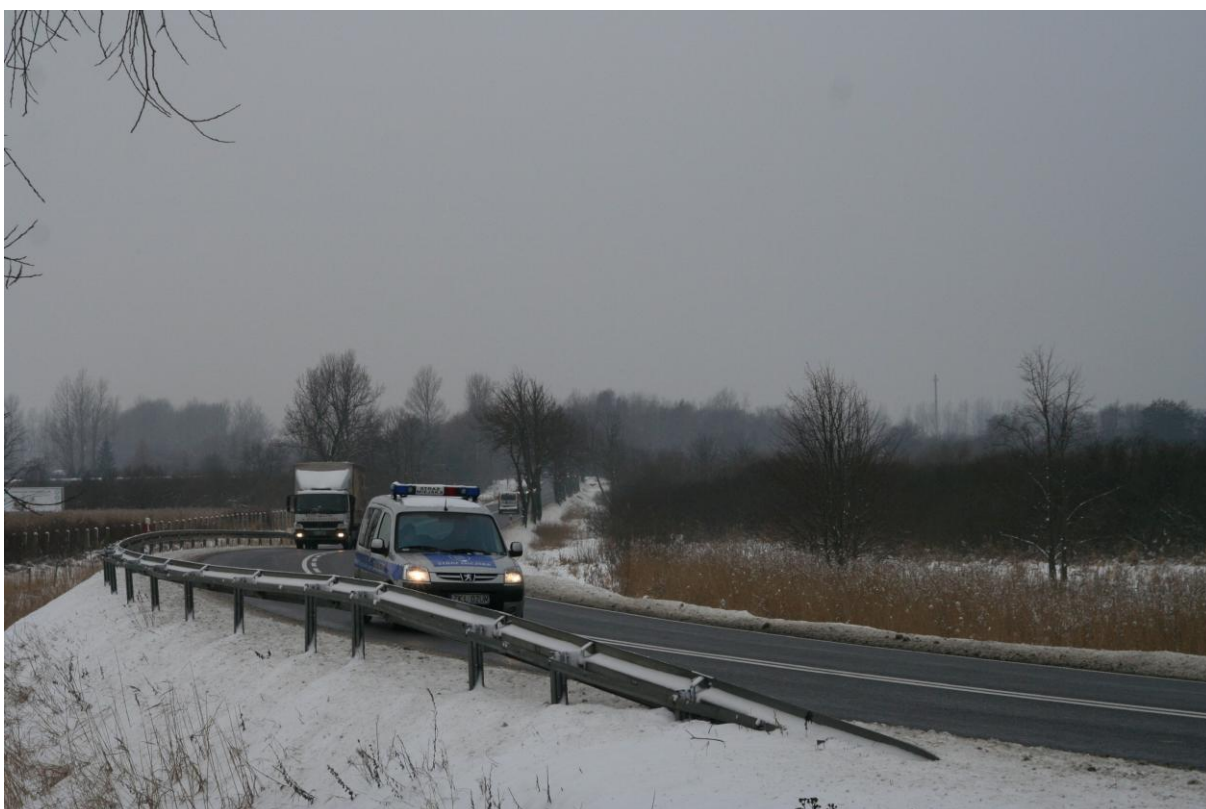
Fot. 6. Droga krajowa 11 rozdzielająca złoża borowiny, biegnąca pomiędzy polami "Koło brzeg I" i "Koło brzeg II".
