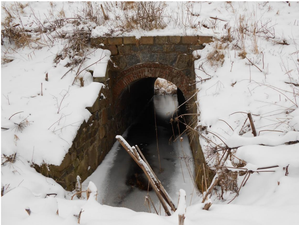
Fot. 11. Przepust pod torami głównego rowu odwadniającego złożę borowiny.
